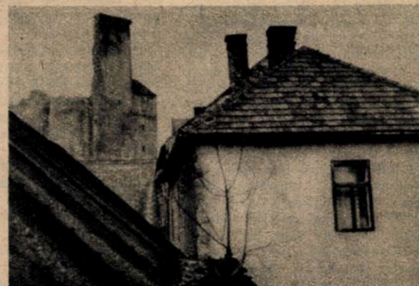
Zadní strana Invalidovy hospody; Haškovu pokoj měl okno v boční stěně. Vedlo na střechu vedlejšího domu a skýtalo pohled vskutku neutěšený.
